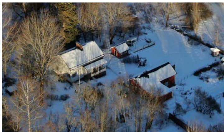
AO-korttelialueella sijaitseva asuinrakennus ja kaksi talousrakennusta.
